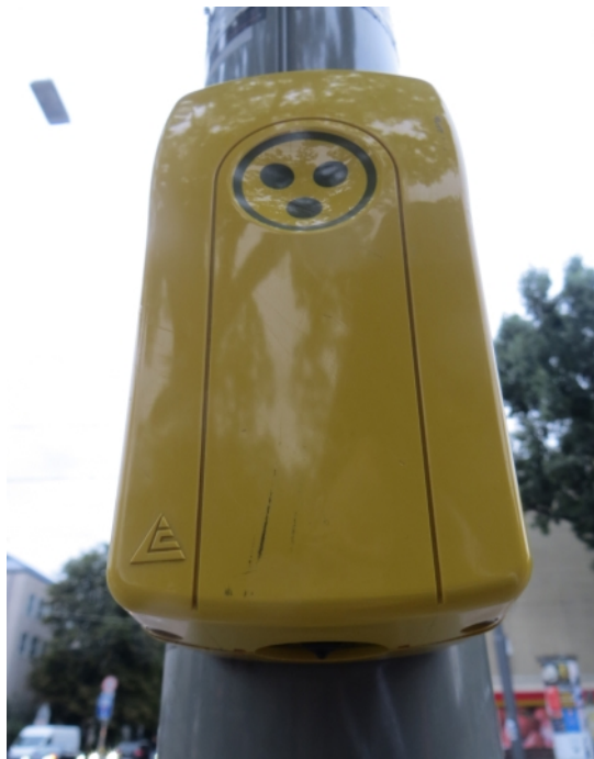
Abbildung 29 Signalgeber an Ampel
