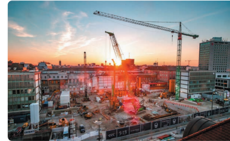
Vorbereitende Arbeiten zum Bau der 2. Stammstrecke - Situation am Hauptbahnhof im Jahr 2021
