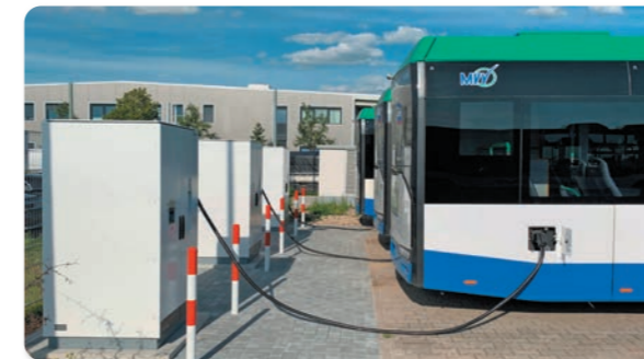
Elektrische MVV-Regionalbusse beim Ladevorgang
