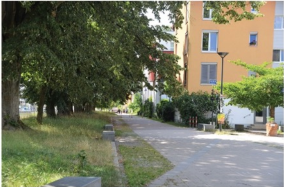
Teilversiegelung eines Gehweges in Freiburg
