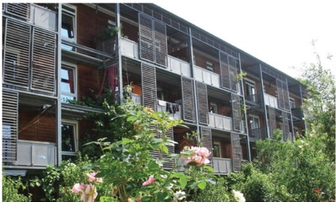
Wärmeschutz in dem Freiburger Stadtteil Vauban mittels Holzlamellen
